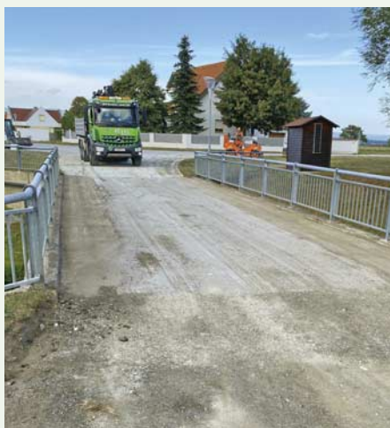
Sanierung Radweg Oslip
